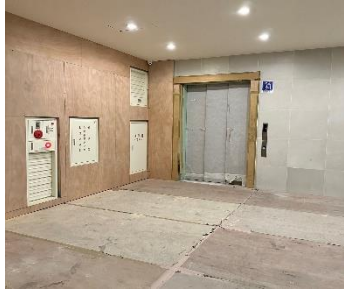
地下 1F 貨梯間
