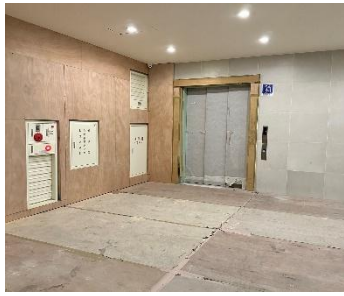
地下 1F 貨梯間
